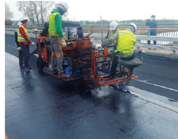
3. 방수층 및 보강층(하이버코트, Geo-Grid)시공
