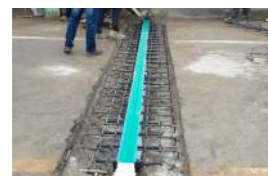
05. 콘크리트 유입방지 테이핑
