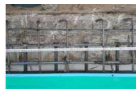
06. 무수축 콘크리트 타설
