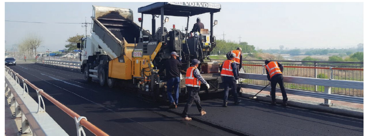
5. 아스팔트 포장층 시공
