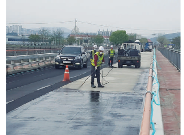
2. 프라이머(Multi Coat-B) 도포
