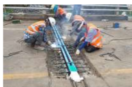
04. 철근 보강 및 신축이음 거치
