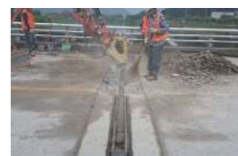
01. 커팅 및 CHIPPING
