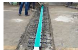
05. 콘크리트 유입방지 테이핑
