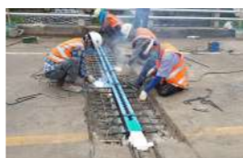
04. 철근 보강 및 신축이음 거치
