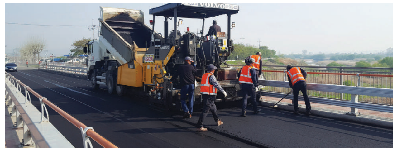
5. 아스팔트 포장층 시공
