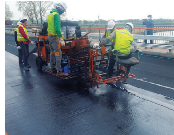
3. 방수층 및 보강층(하이버코트, Geo-Grid)시공
