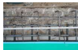
06. 무수축 콘크리트 타설
