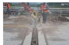
01. 커팅 및 CHIPPING
